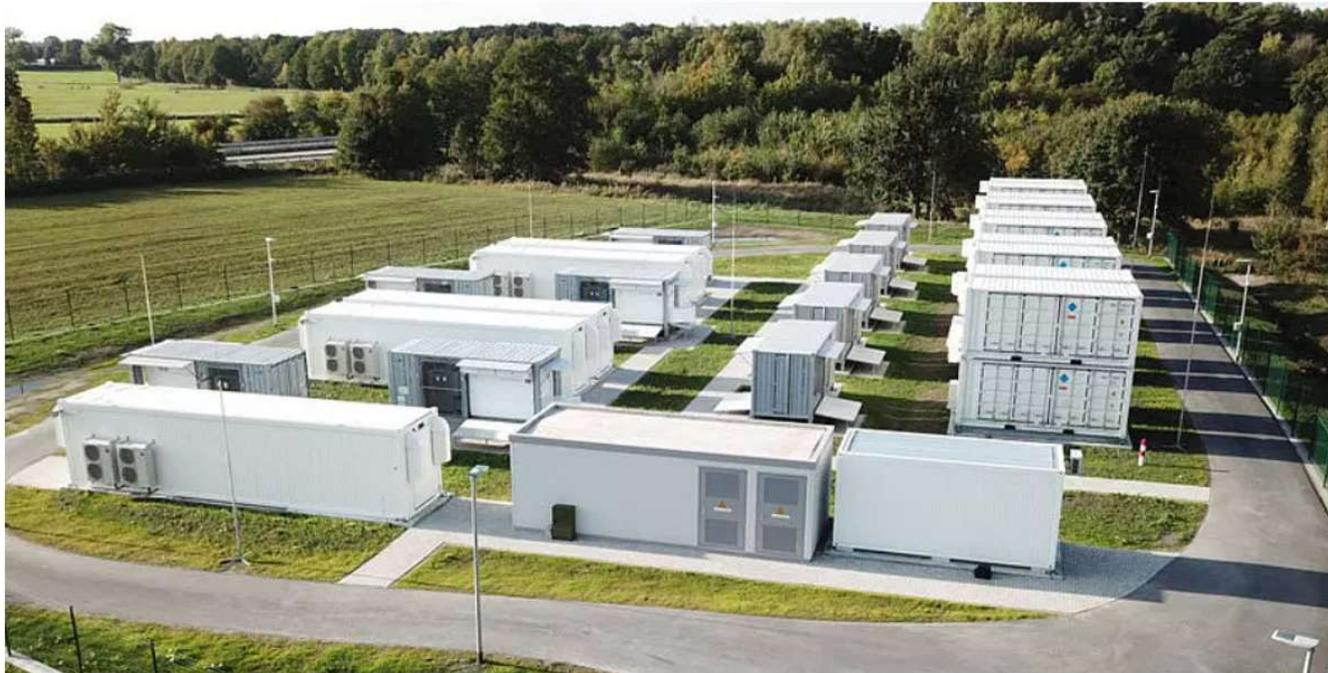
**Der Stromspeicher in Varel besteht aus zwei verschiedenen Batterietypen. Neben Lithium-Ionen sorgen Schwefel-Natrium-Einheiten für mehr Speicherkapazität.**
