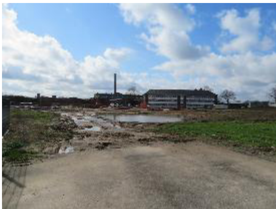
Abb. 14: Baustellenflächen nördlich des Plangebietes
