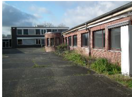
Abb. 3: Verwaltungsgebäude im Süden
