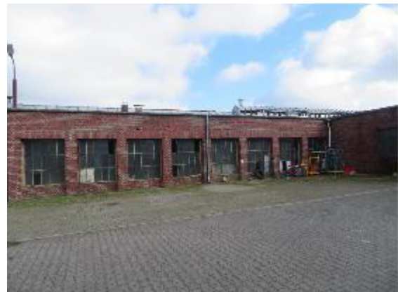
Abb. 9: Außenansicht der Lagerhallen
