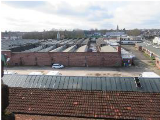
Abb. 6: Blick auf die leerstehenden Hallen im Süden
