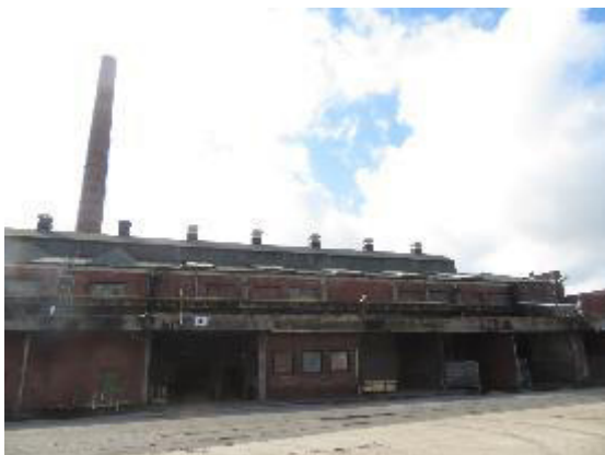
Abb. 10: Nördliche Werkshalle (aktuell in Betrieb)
