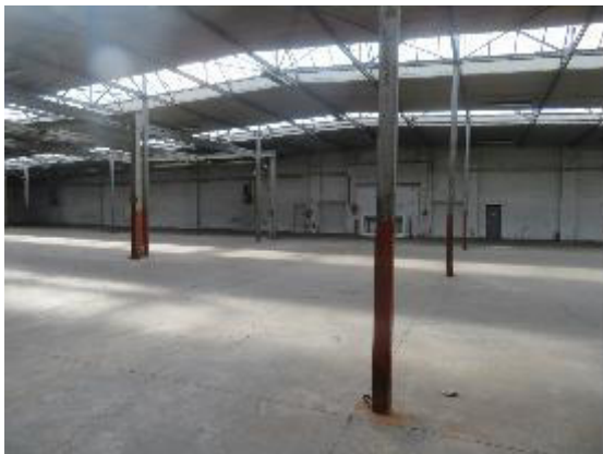
Abb. 8: Innenansicht einer intakten Werkshalle
