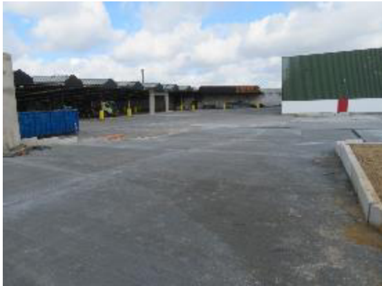
Abb. 12: Neu angelegter Parkplatz und instandgesetzte Lagerhallen
