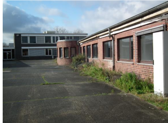
Abb. 3: Verwaltungsgebäude im Süden
