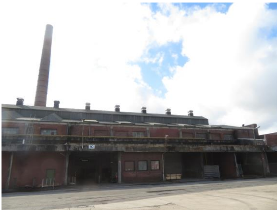
Abb. 10: Nördliche Werkshalle (aktuell in Betrieb)
