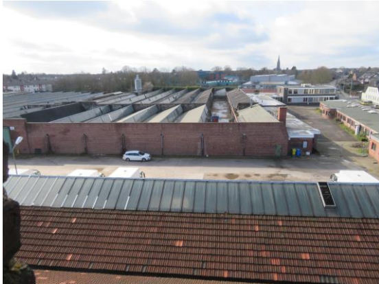
Abb. 6: Blick auf die leerstehenden Hallen im Süden
