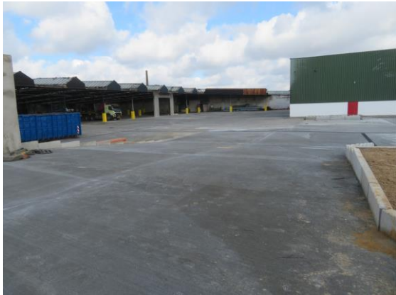
Abb. 12: Neu angelegter Parkplatz und instandgesetzte Lagerhallen
