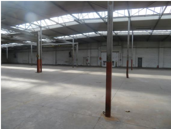
Abb. 8: Innenansicht einer intakten Werkshalle
