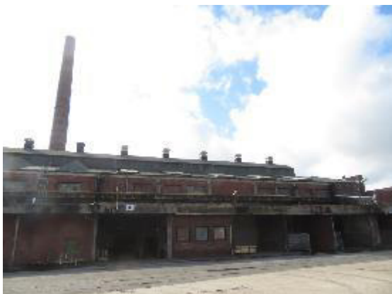
Abb. 10: Nördliche Werkshalle (aktuell in Betrieb)
