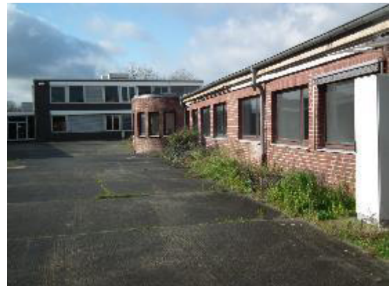
Abb. 3: Verwaltungsgebäude im Süden
