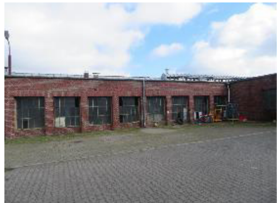
Abb. 9: Außenansicht der Lagerhallen
