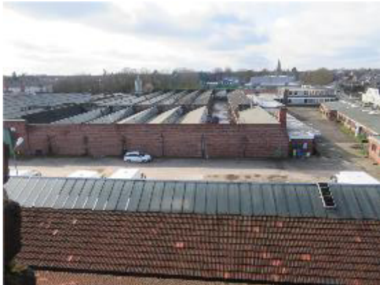
Abb. 6: Blick auf die leerstehenden Hallen im Süden
