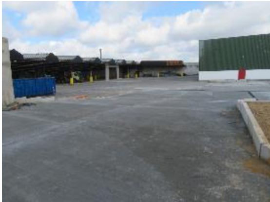
Abb. 12: Neu angelegter Parkplatz und instandgesetzte Lagerhallen
