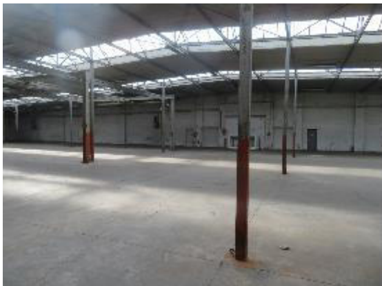
Abb. 8: Innenansicht einer intakten Werkshalle
