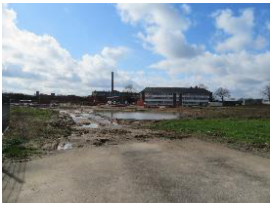
Abb. 14: Baustellenflächen nördlich des Plangebietes
