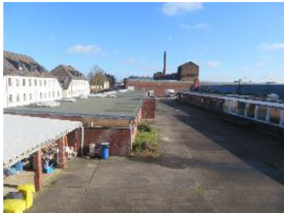
Abb. 2: Blick in Richtung Norden auf die südlichen Verwaltungsgebäude
