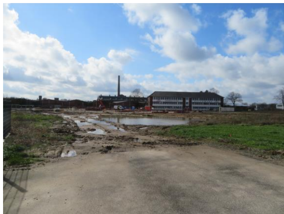
Abb. 14: Baustellenflächen nördlich des Plangebietes
