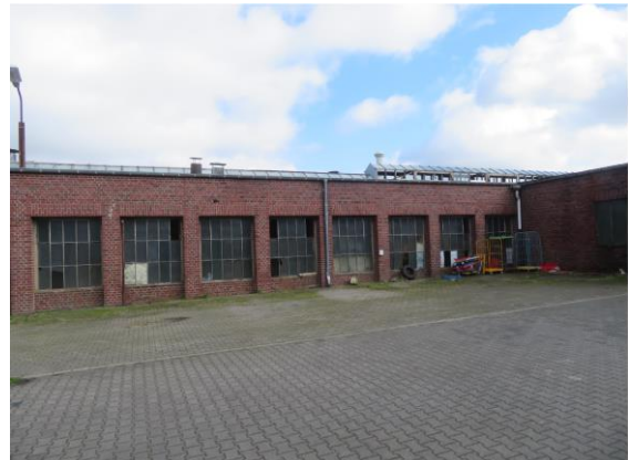
Abb. 9: Außenansicht der Lagerhallen
