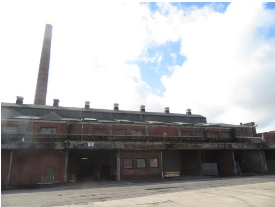
Abb. 10: Nördliche Werkshalle (aktuell in Betrieb)
