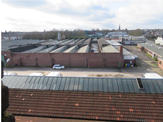
Abb. 6: Blick auf die leerstehenden Hallen im Süden
