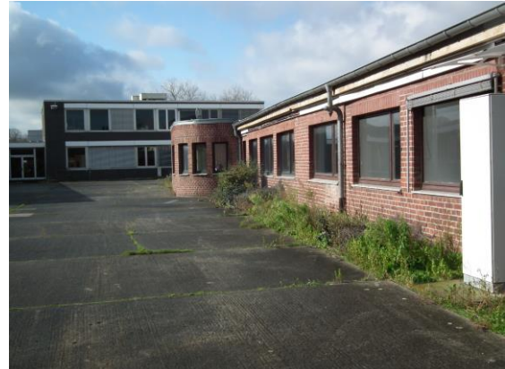
Abb. 3: Verwaltungsgebäude im Süden
