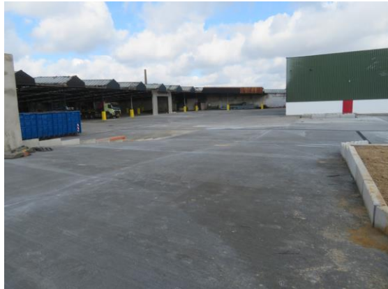
Abb. 12: Neu angelegter Parkplatz und instandgesetzte Lagerhallen
