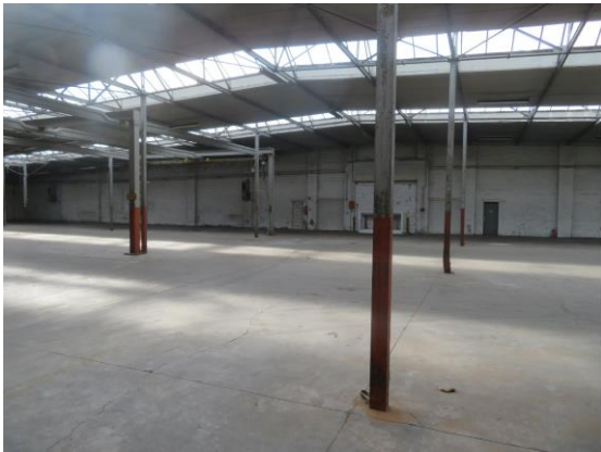
Abb. 8: Innenansicht einer intakten Werkshalle
