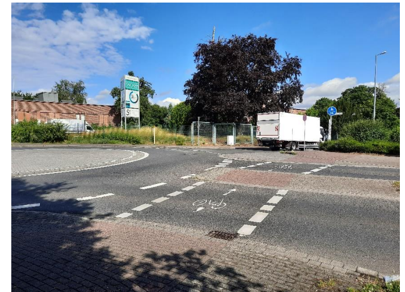
Radwegequerung über die Knotenzufahrt Industriestraße (Nordost)
