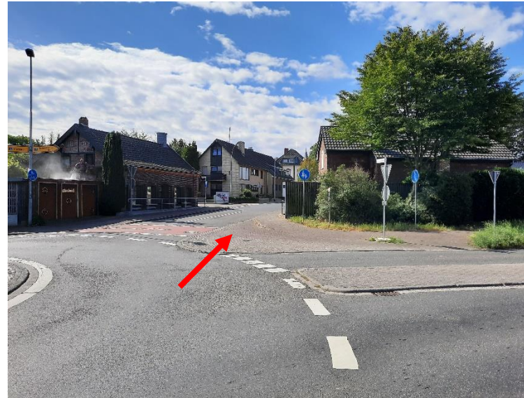
Radwegequerung über den überfahrbaren Bereich in der Kreisausfahrt Bahnhofstraße
